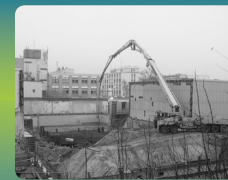
Von 2004 bis 2006 wurde die Neutronenleiterhalle II gebaut. Durch diese Erweiterung konnten weitere Neutroneninstrumente und der Hochfeldmagnet aufgebaut werden.
